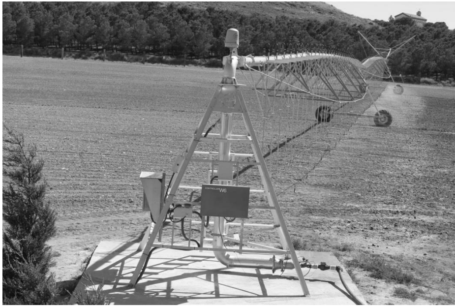
CENTER PIVOT SPRINKLER (PIVOT SIDE)
