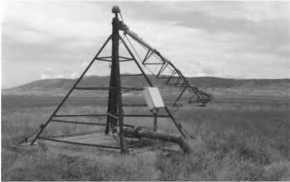
CENTER PIVOT SPRINKLER (PIVOT SIDE)
